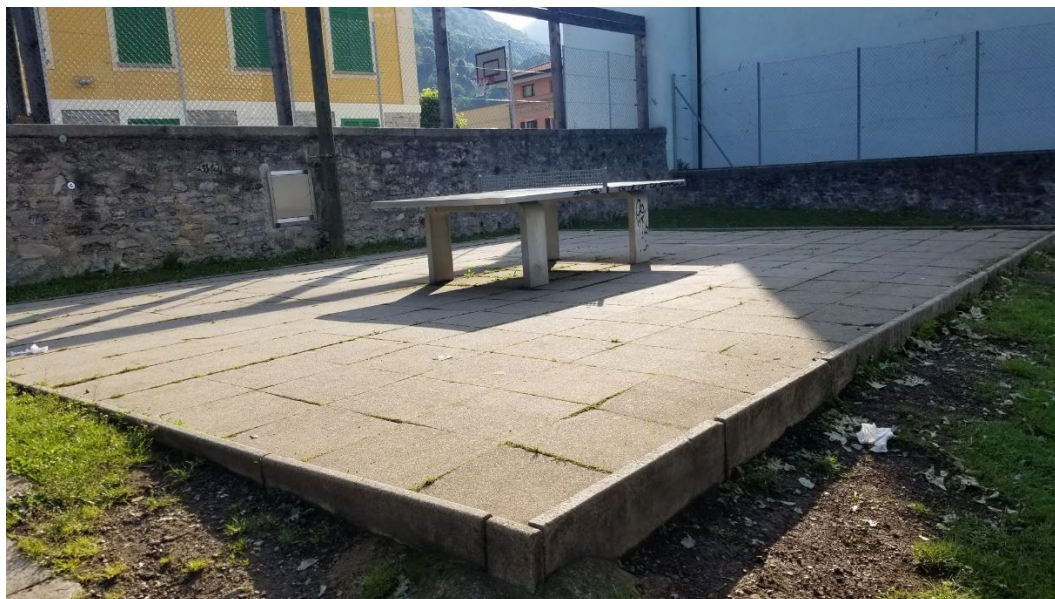
Fig. 4: Area dove attualmente è collocato il tavolo da ping-pong.
